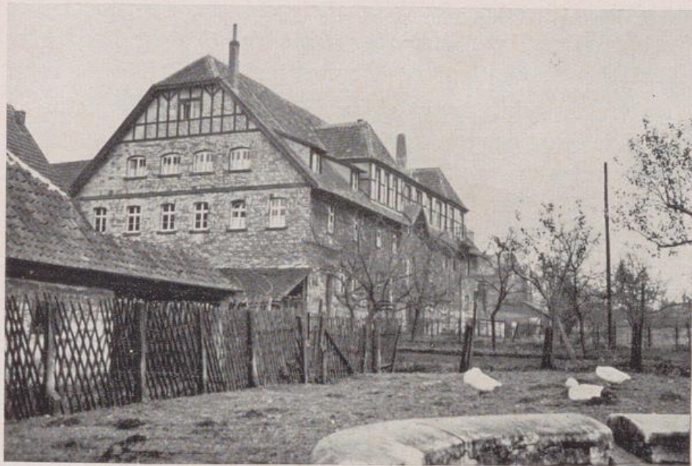
Schulhaus (Matthiges), Ansicht von Nordwesten
