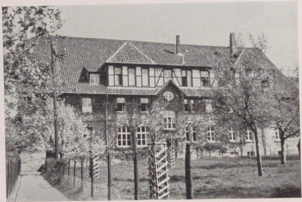
Matthigeshof (jetzt Schulhaus) Frontansicht
