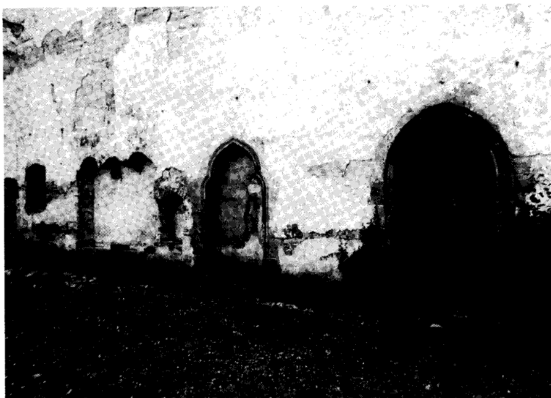
Abb. 10: Böddecken, Südwand des Chores mit Zugängen und Sitznische.
