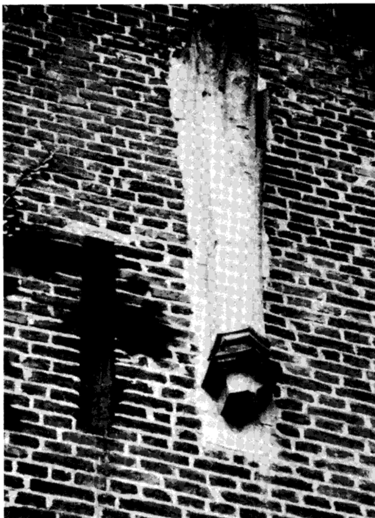
Abb. 7.2: Konsolen und Wölbungsansätze von Augustiner-Chorherrenkirchen aus der Zeit etwa zwischen 1445 und 1485: Frenswegen.
