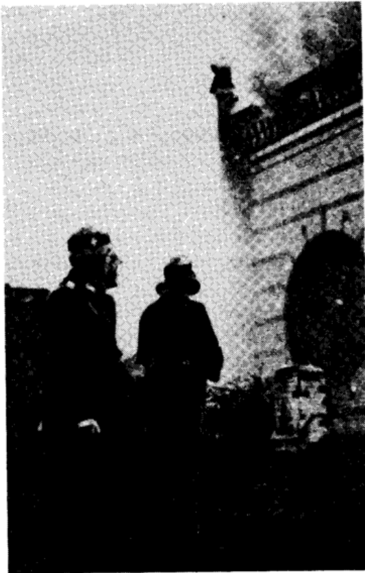
10. November 1938. Brand der Paderborner Synagoge. Die Feuerwehr schützt umliegende Gebäude. Archiv Golücke.
