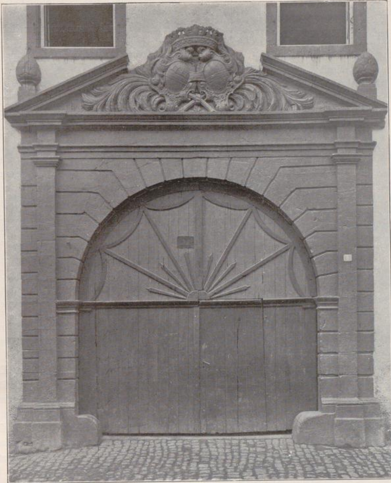
Abb. 254. Portal eines Adelshofes zu Heppenheim.
