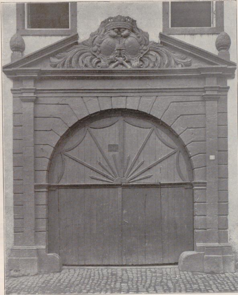
Abb. 254. Portal eines Adelshofes zu Heppenheim.
