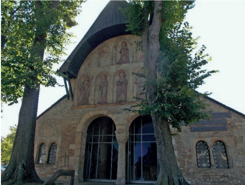
Abb. 1: Goslar, Vorballe des einstigen Domes bei der Kaiserpfalz
