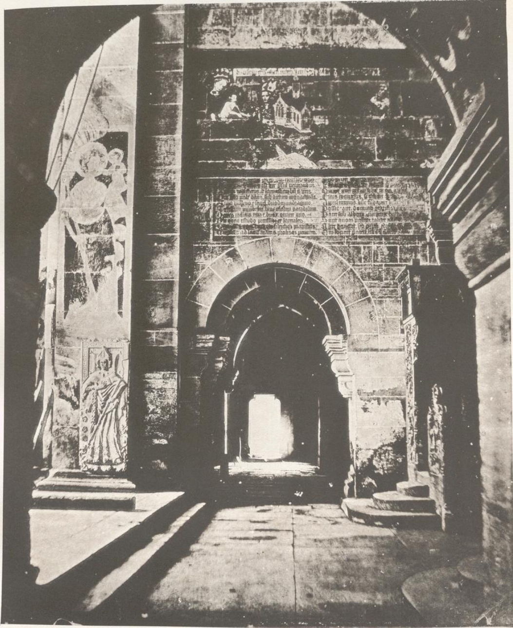
Maulbronn. Südlicher Teil des Querschiffes der Kirche.
