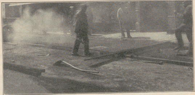
Abb. 2. Herstellung einer Straße in Stampfasphalt; durch die angewärmte Stampfe und Walze wird die pulverförmige Masse über der Betonbettung erhärtet.
