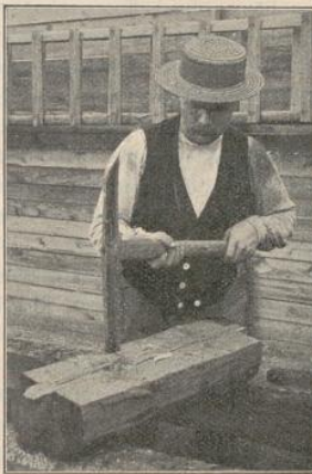
Abb. 2. Bundaxt zum Abbinden der Hölzer verwandt, besonders zum Einhauen der Zapfenlöcher.
