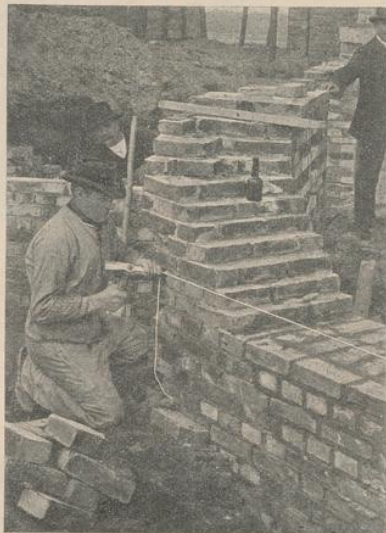
Abtreppen. Abgetrepte Ecke zur Schmutzfestigung.
