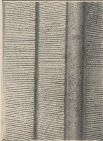
Abb. 2. Aufschlagen der Quaderflächen; der Rundstab an der Ecke ist geschliffen.
