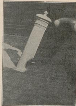
Abb. 4. Abweisstein. Ausführung in Gufseisen als schräg gestellter Cylinders.
