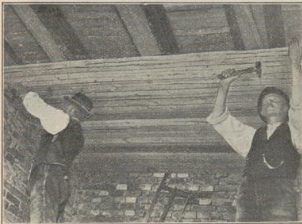
Ausschalen einer Balkendecke, die berohrt und geputzt werden soll.
