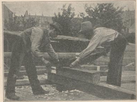
Abschroten eines Holzes mit der Schrotsäge.
