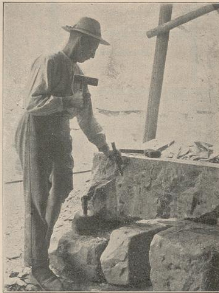
Abb. 3. Abspitzen mit dem Spitzzeisen.
