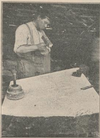
Abstocken eines Werksteins mit dem Stockhammer.
