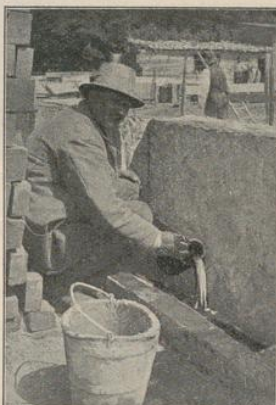
Abb. 2. Ausgießen der Lagerfuge eines Quaders mit Hintermauerung.
