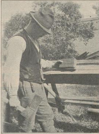
Auslausen, um ein Zapfenloch auszufüllen; dadurch wird die Schwächung des Holzstücks weniger augenfällig.
