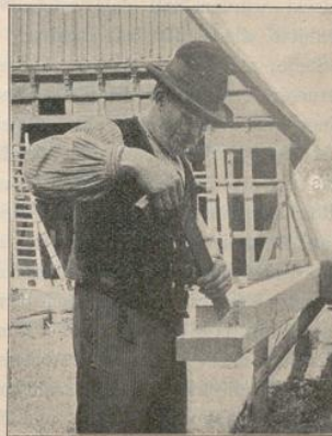
Abb. 3. Stofsaxt wird ohne Stiel benutzt, um Theile von Zimmerwerksverbindungen, Löcher, Zapfen, Blätter u. dgl. nachzuputzen.
