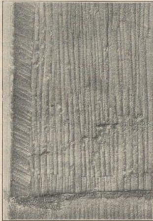
Abb. 1. Nicht aufgeschlagene, sondern nur scharrierte Fläche mit Kantenschlag.
