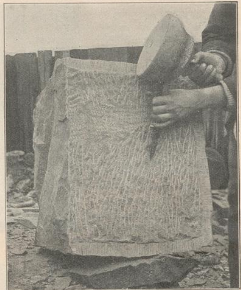
Abb. 4. Abspitzen mit dem Spitzeisen.
