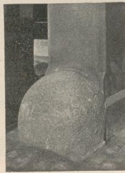
Abb. 2. Abweisstein. Ausführung einfacher und gewöhnlicher Art in Stein.
