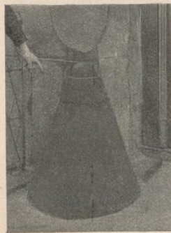
Abb. 1. Abweisstein. Ausführung in Stein in Kegelform.
