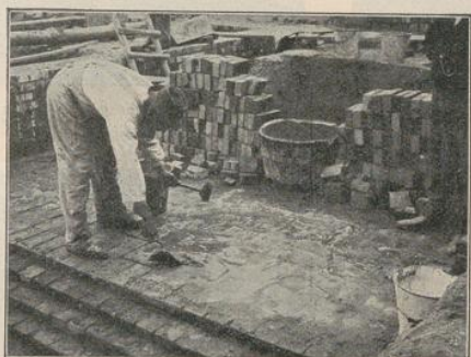
Abb. 1. Ausgießen einer Fundamentmauerschicht, was durch Mörtel geschieht, der mit dem Sprengpinsel flüssig gemacht wird.
