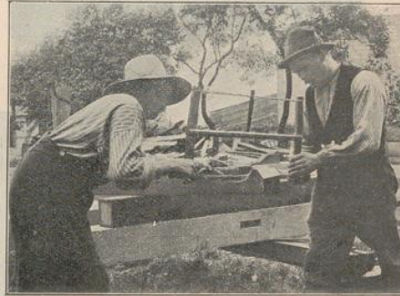
Ausschweifen eines Sparrenendes mit der Schweifsäge nach vorgezeichneter Linie.
