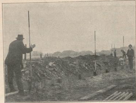
Abfluchten mittels Baken.
