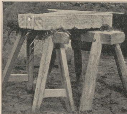
Arbeitszoll. Arbeitsbank mit aufgebänktem Werksteine, dessen obere Fläche bis auf den Rifs als Bruchzoll abgearbeitet werden soll.
