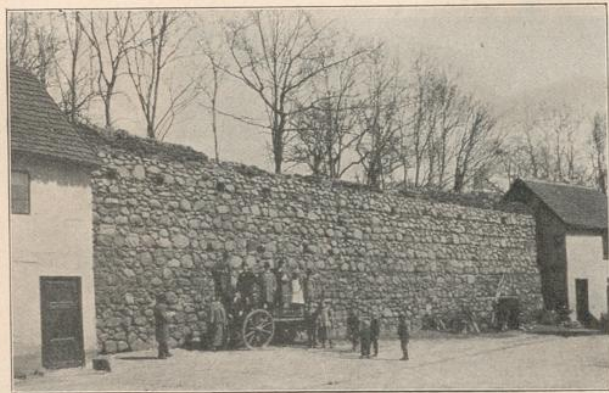
Abgleichen. Eine Stadtmauer aus Bruchsteinen ist nach einigen Schichten jedesmal abgeglichen.
