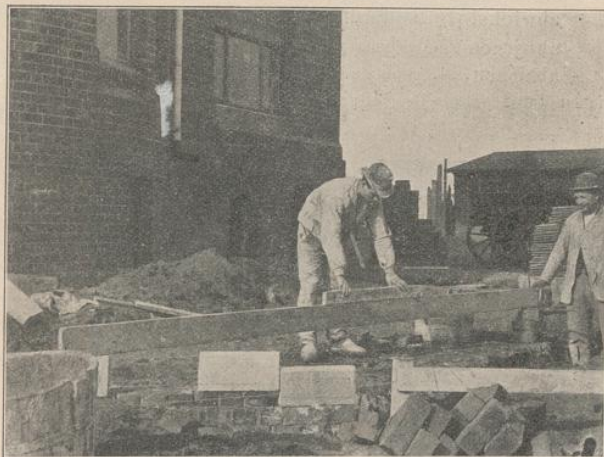
Abwägen mittels Wagscheits und Wasserwage.
