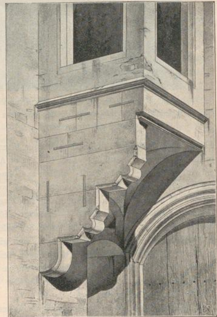
Abb. 3. Ausgekrigte Console in Sandstein mit Verklammerung der einzelnen Steine unter einander (vom „Kühlen Brunnen“ in Halle a. S., Anfang des 16. Jahrhunderts).
