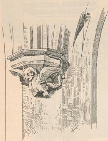
Abb. 8. Console an einem Pfeiler im Mittelschiffe des halleschen Domes, die Gewölbeköppe tragend; frühgothisches Werkstück 1529 wieder verwendet.
