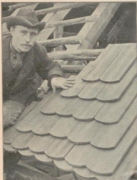
Abb. 7. Dachdeckung. Das Doppeldach.
