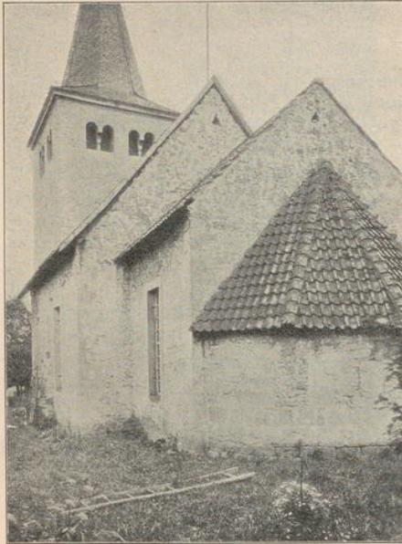
Abb. 20. Dachdeckung. Pfannendach der Apside an der Kirche zu Mahlerten, von rechts her Ueberdeckung; Grate in Hohlziegeln; Andichtung an das Mauerwerk nur durch Eingreifen der Ziegel in den Putz und durch Verstrich.
