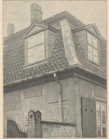
Abb. 21. Dachdeckung. Pfannendach einer Mansarde; Grat durch Schiefer gedichtet; Wangen der Dachfenster verschieden geschiefert und mit Zinkblech ange-dichtet.
