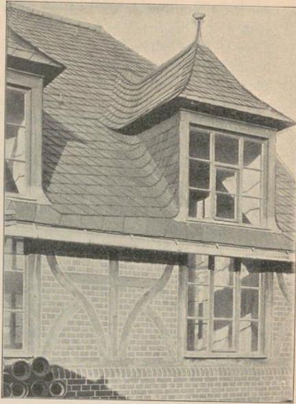
Abb. 45. Dachdeckung. Deutsche Schieferdeckung, Ausschieferung der Kehle zwischen Lucarnen- und Hauptdach; Dachanschluss in Schiefer an die Lucarnenwange; Ueberstand der Ortsteine.
