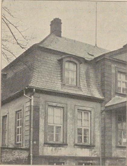
Abb. 40. Dachdeckung. Englische Schieferdoppeldeckung eines Mansardendachs. Der Grat ist in Strackortsteinen eingedeckt. Die Andichtungen sind durch Ausschieferung bewirkt. Die Kehle ist mit Blech eingedeckt. Die Leiterhaken sind auf dem oberen Dachtheile zu sehen.
