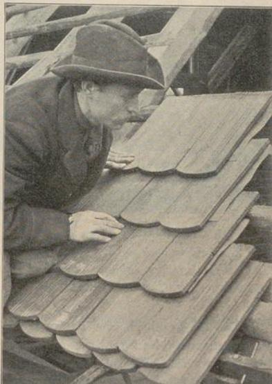
Abb. 6. Dachdeckung. Das Spliefsdach. Eindeckung im Verbande mit Spliefen, die wenigstens den kleinen, noch offen bleibenden Theil der Fugen schliessen. Traufkante mit Doppellage.
