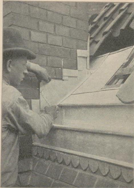
Abb. 11. Dachdeckung. Andichtung an einen Schornstein durch Zinkblech. Ueber das eigentliche Andichtungsblech, welches den Mauerwerksfugen entsprechend geschnitten ist, greift eine Blechkappe, die in einer Fuge durch Verstrich oder durch eiserne Haken Halt bekommt und das Eindringen des am Schornsteine herabfließenden Wassers verhindert.
