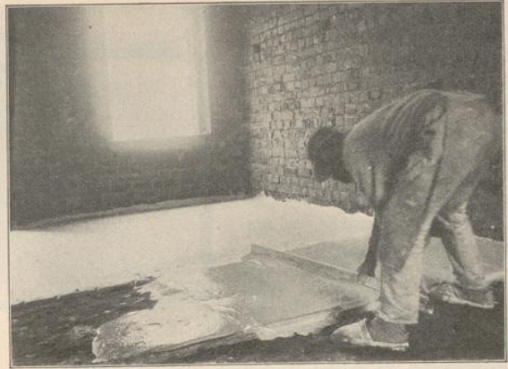
Abb. 1. Gipsestrich. Abziehen des Gipsgusses zwischen Lehrplatten mit dem Richtscheite.
