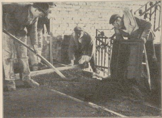
Abb. 2. Cementestrich. Herstellung der Unterlage für den Estrich in Schlackenbeton. Rechts ist die Masse in einem Tragekasten herbeigebracht und ausgeschüttet; sie wird mit der Schaufel zwischen Lehrplatten geebnet, mit einem Richtscheite abgezogen und dahinter mit einer Stampfe, einem quadratischen Bohlenstücke mit Stiel, festgestampft. Links ein breites fertiges Stück der Unterlage.
