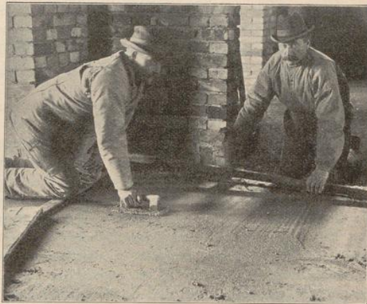
Abb. 4. Cementestrich. Rechts Entfernung der Lehrlatten; links Abreiben des abgezogenen Estrichs mit dem Reibebrette.
