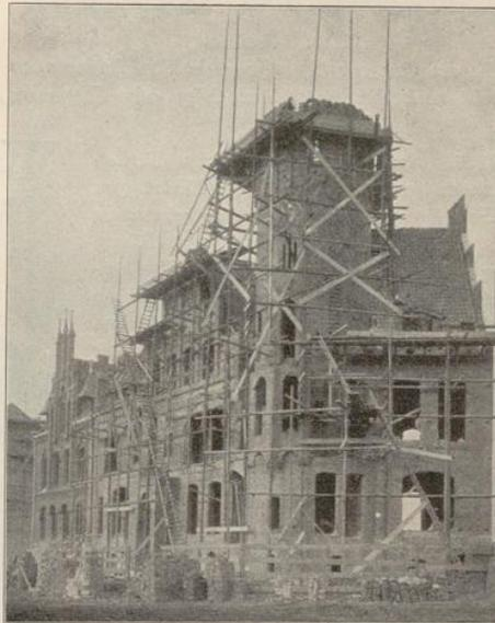
Abb. 2. Gerüst. Stangengerüst, wie es zu gewöhnlichen Backsteinbauten ausgeführt wird. Die Standbäume sind durch Streichstangen verbunden und an verschiedenen Stellen durch schräg oder kreuzweise gelegte schmale Bohlen abgeschwertet. Die auf den Netzriegeln liegenden, den Fußboden der Gerüstgeschosse bildenden Bohlen sind durch Leitern mit Podestunterbrechungen oder auf Rampen aus Bohlen zu erreichen. Vor den Gerüstbohlen Bohlenbrüstungen.
