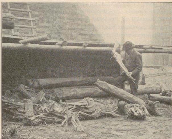
Abb. 12. Gründung. Pfähle, die bei dem Einrammen zerschlagen und deren Fasern völlig gelockert sind.
