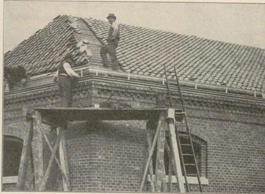
Abb. 1. Gerüst. Bockgerüst, hier aus zwei Böcken mit Gerüstbohlen bestehend und für Dachdecker und Klempner dienend.
