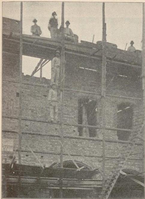
Abb. 6. Gerüst. Verlängerung der Standbäume, Aufpfropfung, durch Zusammenbinden beider Bäume auf etwa 4,0 m Länge mit Tauen. Der obere Baum steht auf einer an den unteren angenagelten Knagge auf oder er wird auf einen Durchbinder gesetzt. Rechts ist die Verlängerung durch angenagelte Lattenstücke noch mehr befestigt so wie in Abb. 7.
