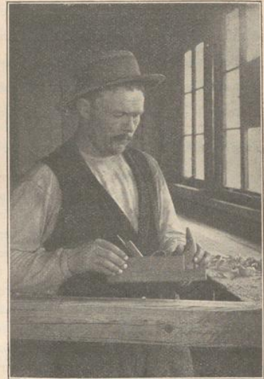
Abb. 1. Hobel. Der Schropphobel, ein Fausthobel, hier vom Zimmermann zum Glätten von Bauholz gebraucht.
