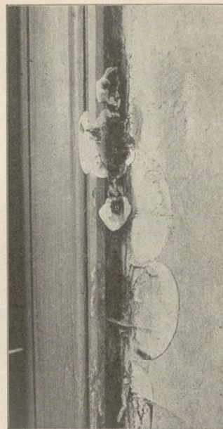
Abb. 6. Hausschwamm. Die Fladenbildung der Abb. 5 vergrößert.
