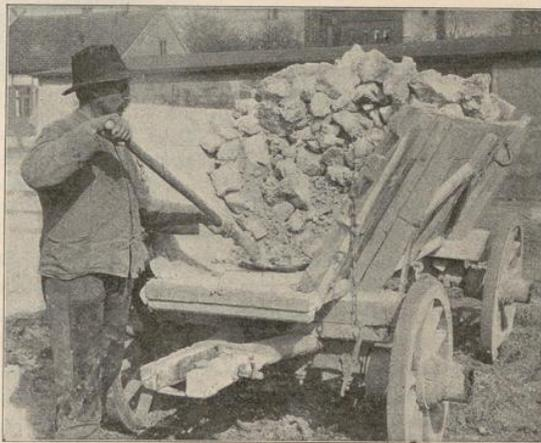
Abb. 1. Kalk, wie er in gebranntem Zustande auf der Baustelle angefahren wird, um alsbald gelöscht zu werden.
