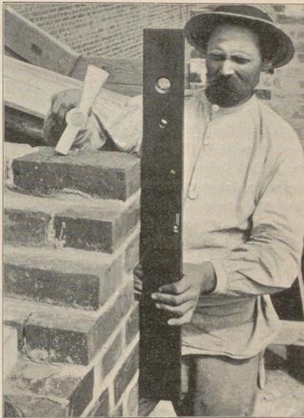
*Libelle, welche die Form der gewöhnlichen Wasserwage hat. In der Mitte der Langseite die Glasröhre zur Bestimmung wagerechter Richtung, am oberen Ende in kreisförmiger Durchbrechung die Glasröhre zur Bestimmung lothrechter Richtung, die von dem Maurer hier zur Ausführung des Mauerwerks beabsichtigt wird.*
