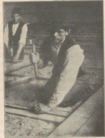
Lasche. Auffütterung oder Aufwaschung der Balken durch Leisten, um für die Dielen ein wagerechtes Auflager zu schaffen; den Balken werden je nach deren ungleicher Oberfläche Leisten in der entsprechenden Stärke aufgenagelt.
