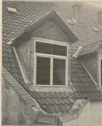
*Lucarne auf einem Ziegeldache; die Backen von Schiefer bekleidet und durch Zinkblech dem Hauptdache angedichtet; Andichtung der Vorderseite durch Blei. Das Lucarnendach in Ziegeln mit Zinkkehle; die Orte durch Windfedern gedichtet.*
