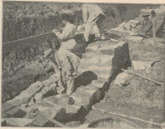
Abb. 54. Mauern in Bruchstein für Fundamente. Die Höhenlage wird mittels Latte und Wasserwaage bestimmt; vorn Ausfüllung des Mauerinneren durch passende Steine in vollem Mörtel.
