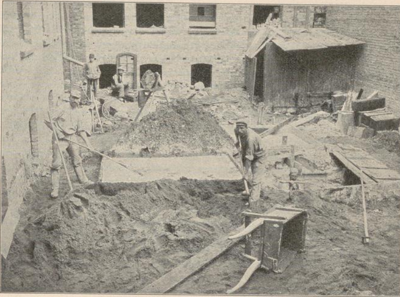
Abb. 3. Mörtel. An der Kalkgrube hinten die Löschbank mit Schieber, um den gelöschten Kalk — rechts im Hintergrunde noch etwas ungelöschter — in die Grube abzulassen. In letzterer, die theilweise überdeckt ist, damit nichts hineinfällt, steht ein Arbeiter, um den Kalk in die Kalkmacherbank unmittelbar (links) neben der Grube einzuschaufeln, während ein zweiter Arbeiter den in einer Karre zugefahrenen, vorn lagernden Sand einschaufelt und ein dritter mittels Kalkkrücke, wie sie zufällig rechts liegt, die Mischung durcharbeitet, welcher das erforderliche Wasser in einer auf der Löschbank liegenden hölzernen Rinne zugeführt ist. Zwischen Löschbank und Kalkmacherbank ist fertiger Mörtel aufgehäuft; dahinter ein Ladebock mit einem Kasten voll Mörtel, fertig zum Abtragen in die Kalkkasten der Maurer.
