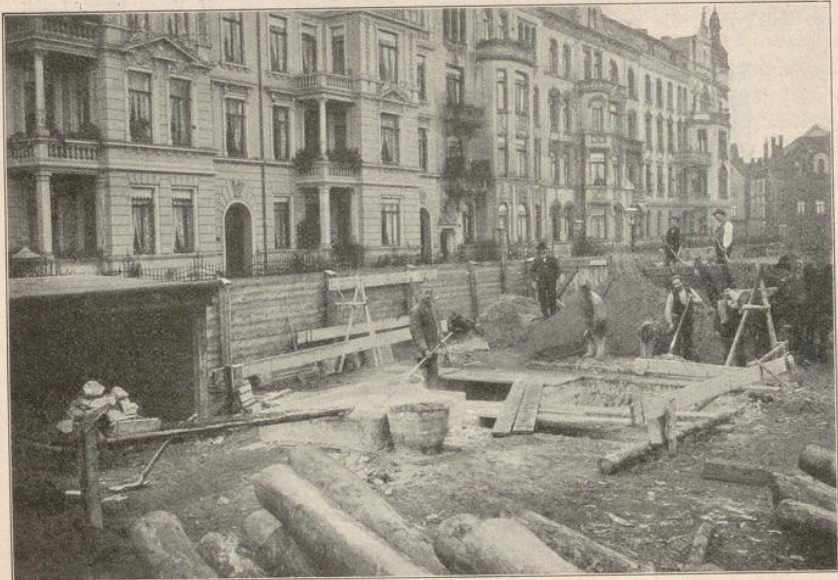
Abb. 2. Mörtel. Links Lagerschuppen für ungelöschten Kalk, der mittels Karre zur Löschanke befördert wird, wo ein Arbeiter ihn zum Löschen bringt. Der Löschanke wird durch eine hölzerne Rinne das Löschwasser zugeführt; der Arbeiter vertheilt es mittels Krücke unter den Kalk. Hinter dem Arbeiter zwei Gruben, von denen die eine mit dem gelöschten Kalk gefüllt wird, während der Kalkinhalt der anderen auf der Kalkmacherbank zu Mörtel verarbeitet wird, womit die Arbeiter hinter diesen Gruben beschäftigt sind. Rechts steht der Ladebock mit dem Kasten zum Abtragen des fertigen Mörtels zu den Arbeitsstellen. Im Hintergrunde wird Sand angefahren.
