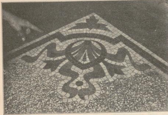
Abb. 1. Mosaik. Eckstück eines modernen Terrazzo-Fußbodens als Mosaik von farbigen (Marmor-) Steinen ausgeführt.
