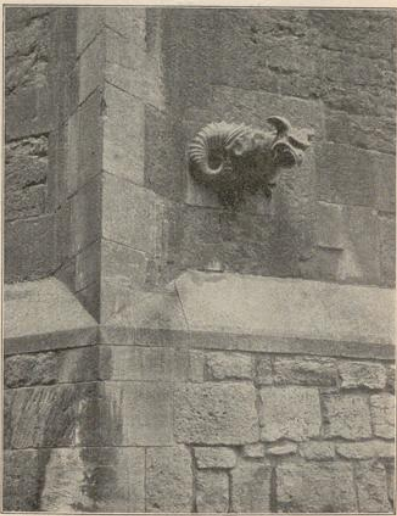
Abb. 4. Mauern. Bruchsteinverband in lagerhaften Steinen, in die die Werkstücke für die structiven Theile gut einbinden. Zwickel kaum noch bemerkbar.
