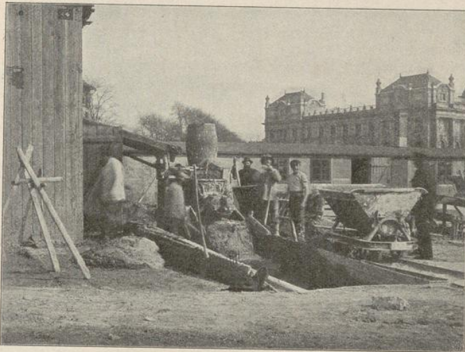
Abb. 1. Mörtel. Bereitung des Kalkmörtels durch Mörtelmaschine.
