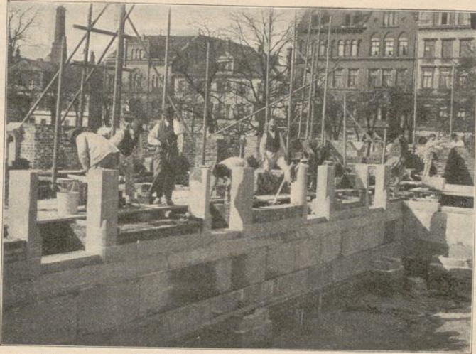
Abb. 12. Mauern. Versetzen von Werkstücken zu Fenstergewänden, zwischen denen hier die Fensterpfeiler in Backstein ausgemauert werden.
