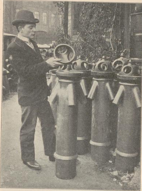
Abb. 36. Schornsteinaufsatz in glasiertem Thon. Der in die rohrförmigen Ansätze stoßende Wind, woher er auch kommt, verstärkt den Zug des Rauches in der Richtung nach oben. Im Hintergrunde sind einfach cylindrische Aufsätze zu bemerken.
