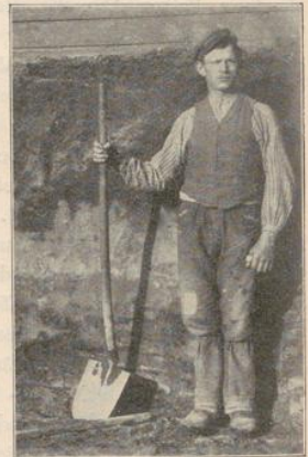
Schippe oder Handschaufel zum Ausheben des Erdbodens der Baugrube, auch sonst auf der Baustelle viel benutzt.
