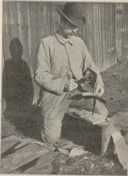
Schieferhammer mit Dachbrücke oder Schieferambofs, wie sie seit Alters zur Bearbeitung des Schiefers für die Dachdeckung in Gebrauch sind.
