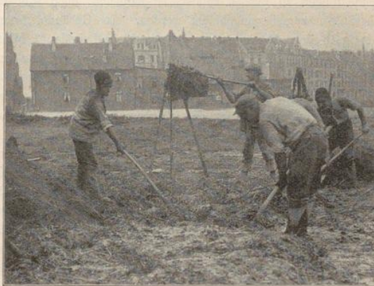
Strohlehm in Zubereitung aus gehacktem Stroh, das mit dem Lehme gut durchgemengt wird. Auf einem Bocke im Hintergrund ein mit fertigem Strohlehm gefüllter Kasten zum Abtragen an die Verbrauchsstelle.
