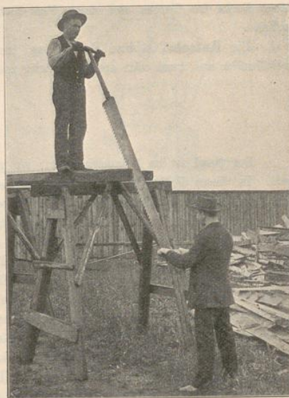
Säge. Brett-, Kloben-, Längensäge zum Trennen von Bauhölzern und Bohlen, etwa 2,5 m lang, mit großen Zähnen; oben ein fester Quergriff, unten ein abnehmbarer, um ohne Schwierigkeit das Blatt an passender Stelle hinter dem Gerüstbocke einsetzen zu können.
