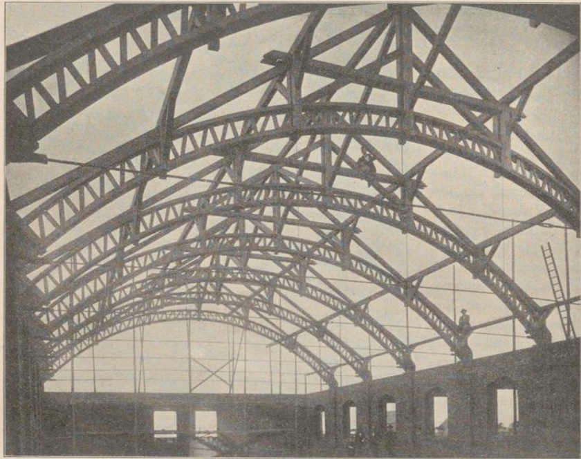
Abb. 2. Stephan-Dach über dem Reithause des städtischen Kasernen-Neubaues in Grimma. Ueber dem bogenförmigen Binder ist durch hölzerne Aufbauten ein Satteldach mit geraden Flächen hergestellt.
