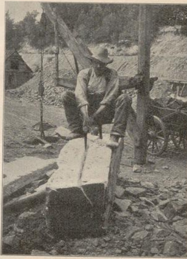
Schrot. Herstellung der Rille, in welche Keile eingetrieben werden, um ein Stück Stein von bestimmter Größe abzusprengen.
