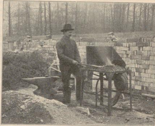
Schmieden. Eine Feldschmiede, wie sie verwendet wird, wo Schmiedarbeiten auf der Baustelle hergestellt werden müssen. Vorn eiserner Herd mit Gebläse, links dahinter Ambos mit Hammer.
