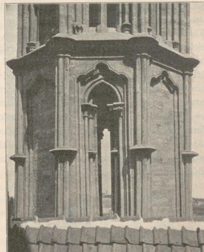
Abb. 31. Säulen der Uebergangszeit, gebündelt und mit Bunden, von dem Thurme der Kirche in Arnstadt i. Th.
