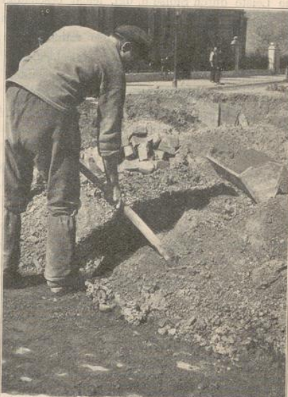
Schlacke. Steinkohlenschlacke wie sie zum (Schlacken-) Beton sowie zu Hinterfüllungen gebraucht wird.
