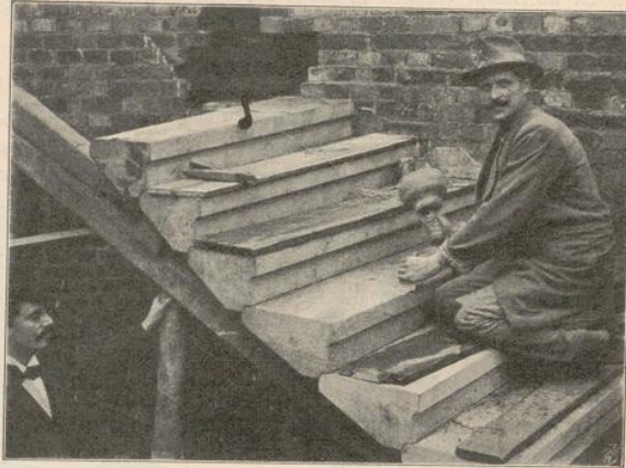
Abb. 18. Freitragende Treppe in der Herstellung. Die oben gewendelten Stufen sind auf einem Gerüste gelagert und werden erst nachträglich in stückweise ausgebrochenes Mauerwerk mit Cement vermauert. Abdeckung der Auftritte während der Ausführung durch Bretter.
