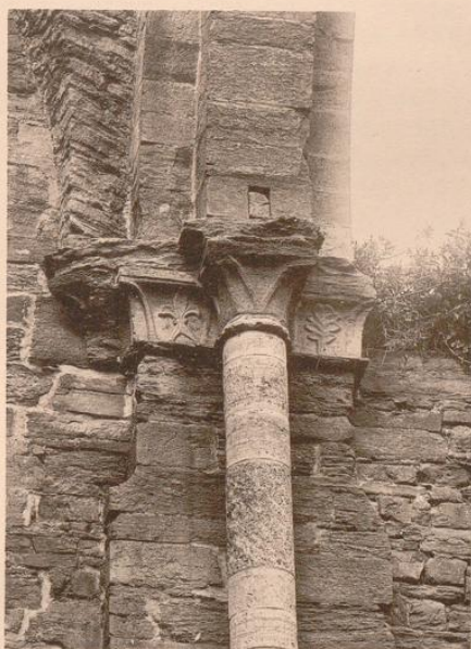
Obere Teile des südlichen Westwandpfeilers im Langhaus.
