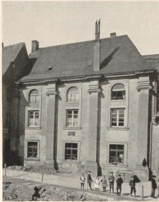
Abb. 283. St. Afra. Ansicht von Osten.
