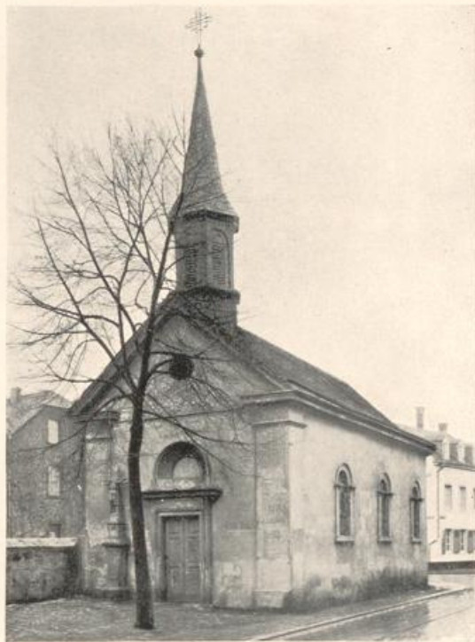
Abb. 282. Ehem. Kapelle Zurlauben.
