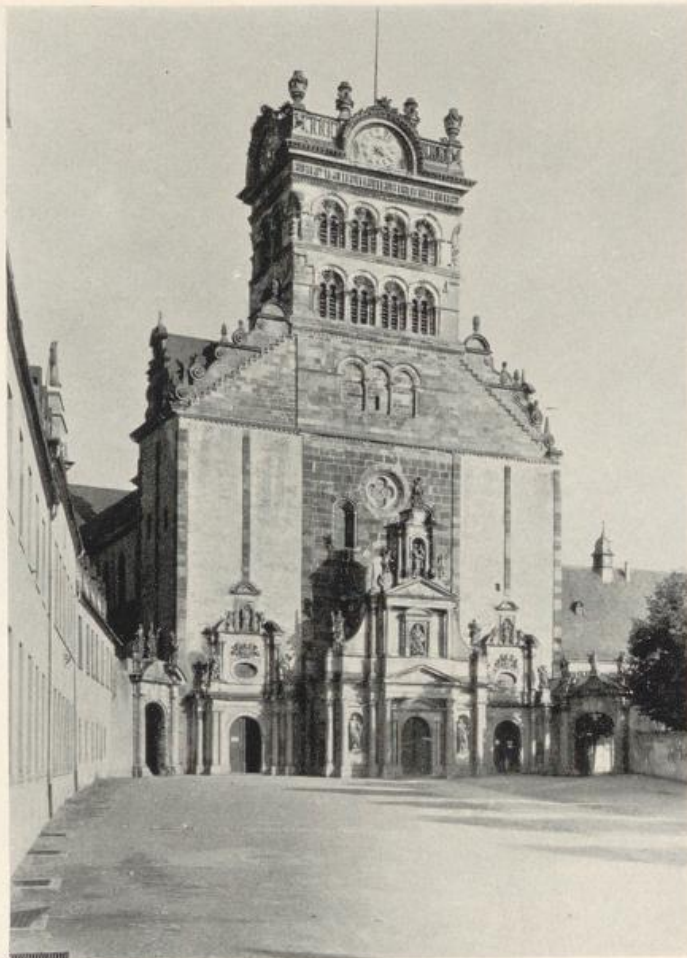
Abb. 10. Abteikirche St. Matthias, Westfassade.
