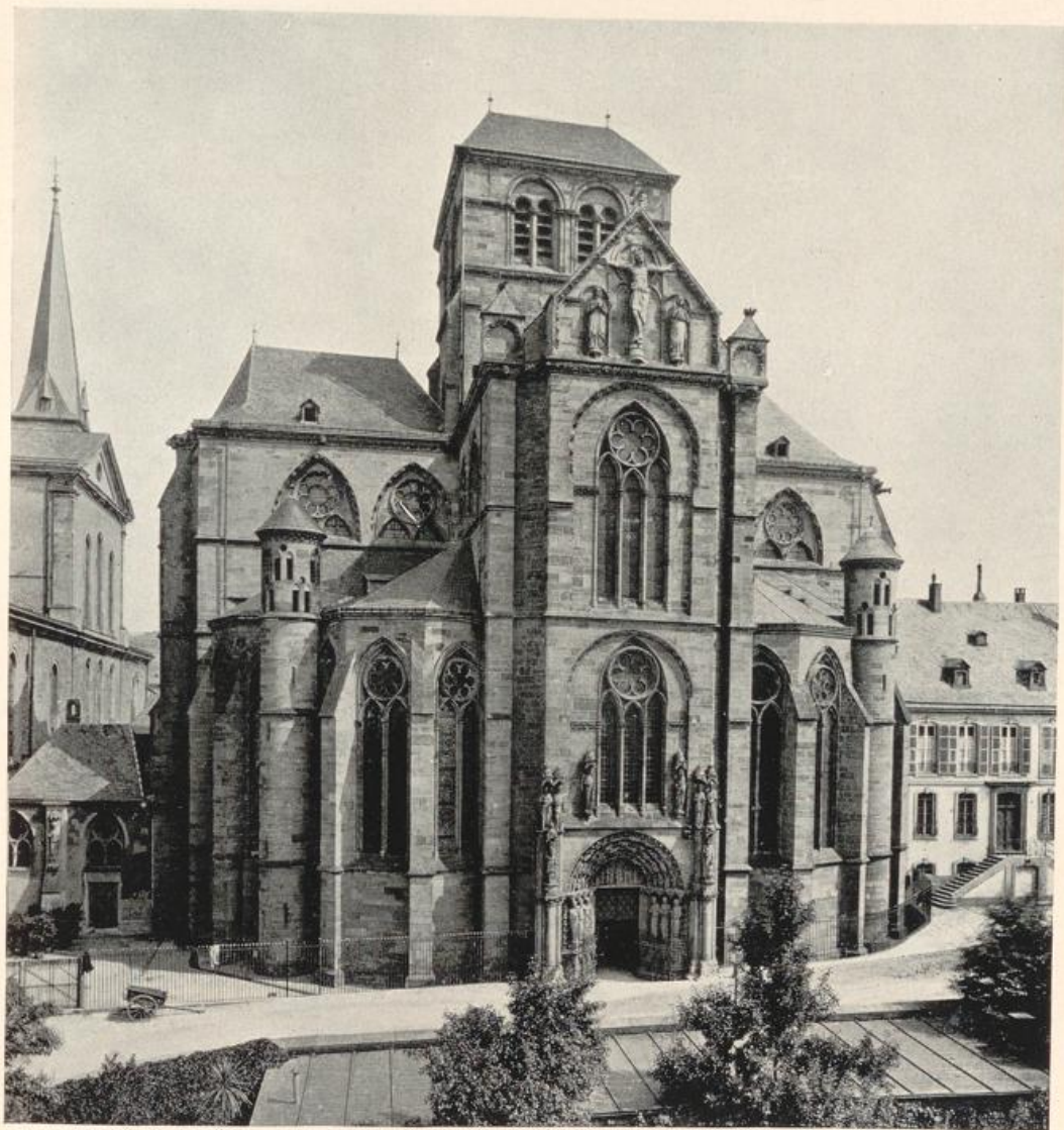
Abb. 102. Liebfrauenkirche, Ansicht von Westen.
