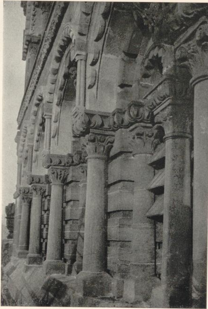
Abb. 182. Matthiaskirche. Westturm. Untergeschoß.
