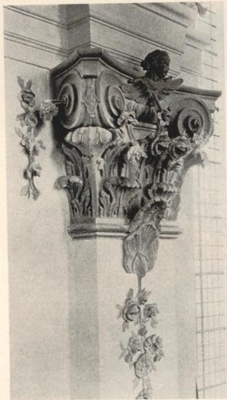
Abb. 244. Paulinuskirche. Pilasterkapitell nach der Instandsetzung.
