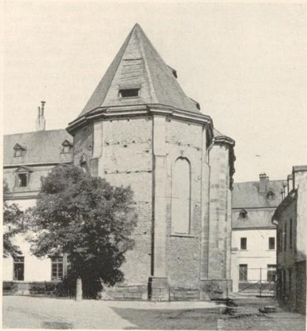
Abb. 303. Ehem. Katharinenkirche. Chor von Osten.
