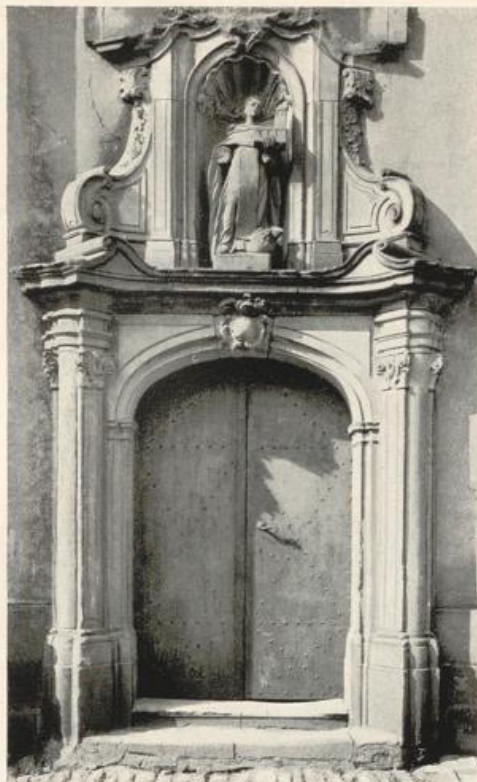
Abb. 304. Ehem. Katharinenkirche. Portal.
