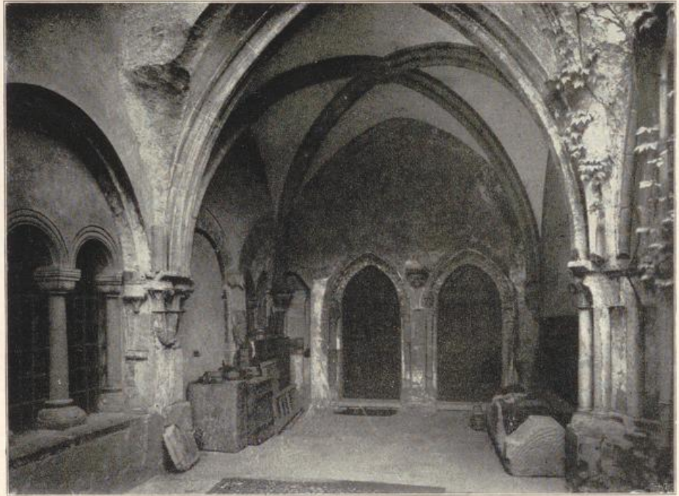
Abb. 206. St. Matthias. Vorhalle zum ehem. Kapitelsaal. Nordflügel des Kreuzganges.
