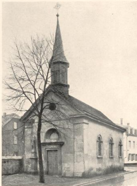
Abb. 282. Ehem. Kapelle Zurlauben.
