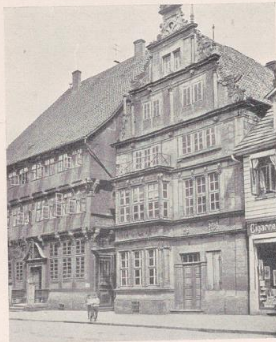
Bild 27. Hameln, Osterstr. 9, erbaut 1589 (nach Ebinghaus: „Das Ackerbürgerhaus der Städte Westfalens und des Wesertals“)
