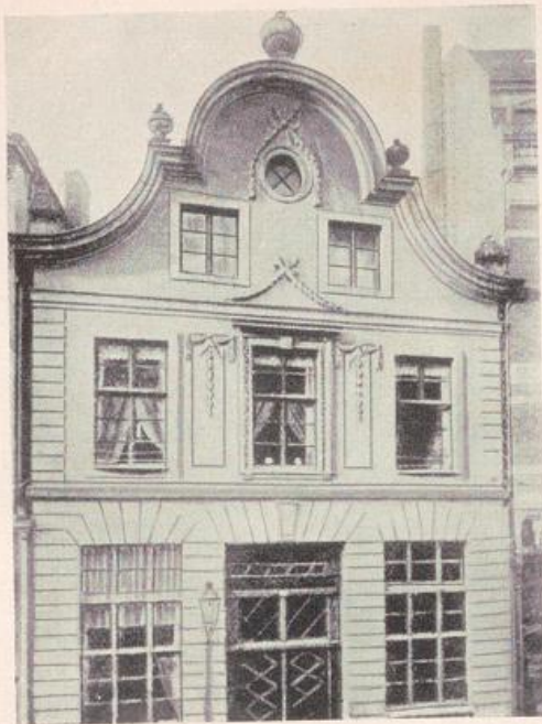
Bild 32. Osnabrück, Biedermeierhaus auf der Großen Straße
