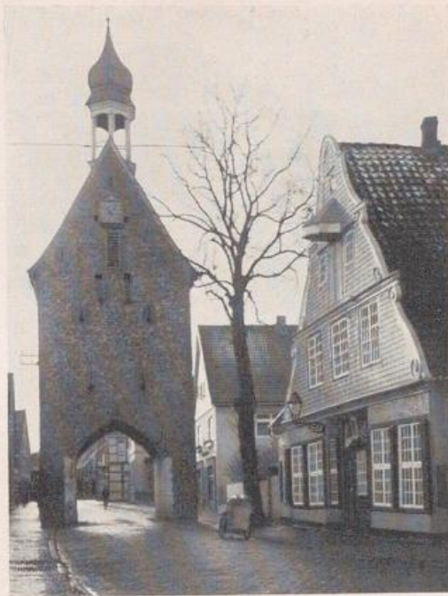
Bild 18. Quakenbrück, Hohe Pforte Patrizierhaus
