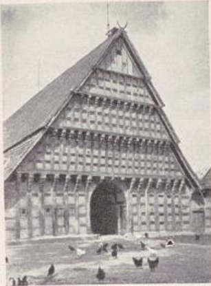
Bild 9. Giebel der Wehlburg, freier Bauernhof in Wehdel bei Quakenbrück (nach Niedersachsen, Okt. 1930)
