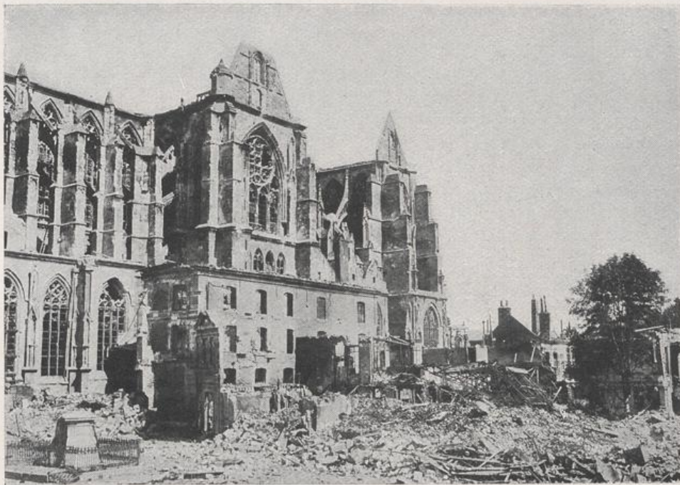
St. Quentin. Die Kathedrale von Südwesten nach dem Brande, August 1917
