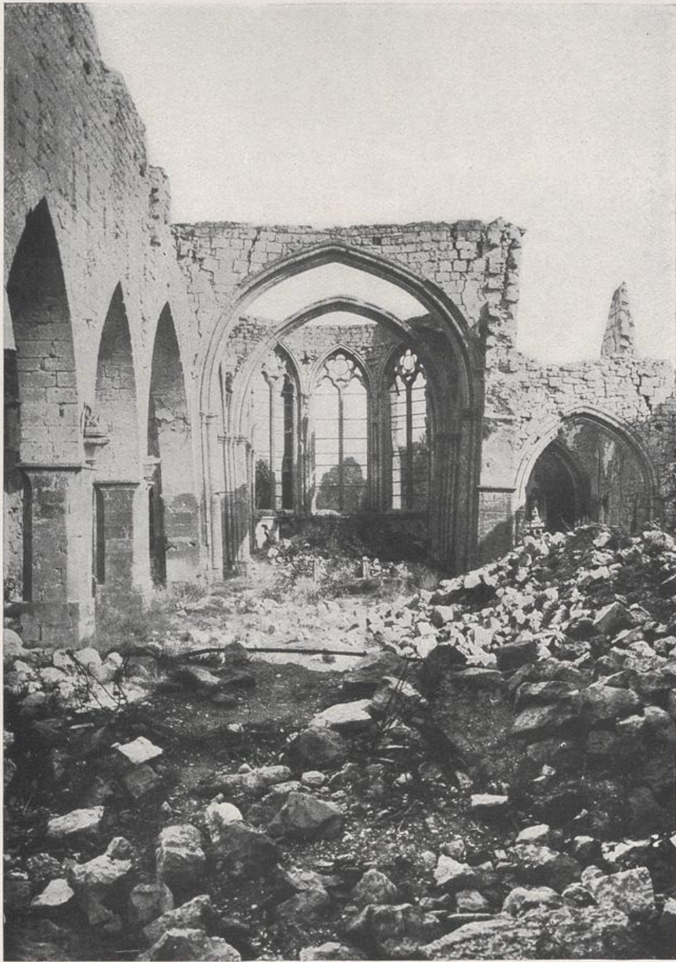
Varennes. Die von den Franzosen zerschossene Kirche
