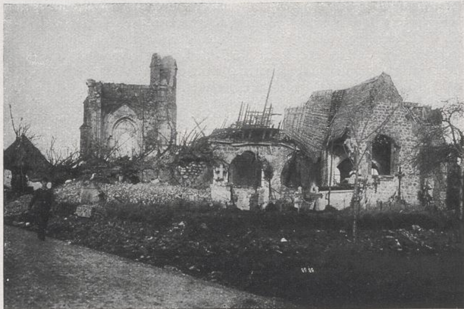
Crapeaumesnil. Die von der feindlichen Artillerie völlig zerschossene Kirche, 1916
