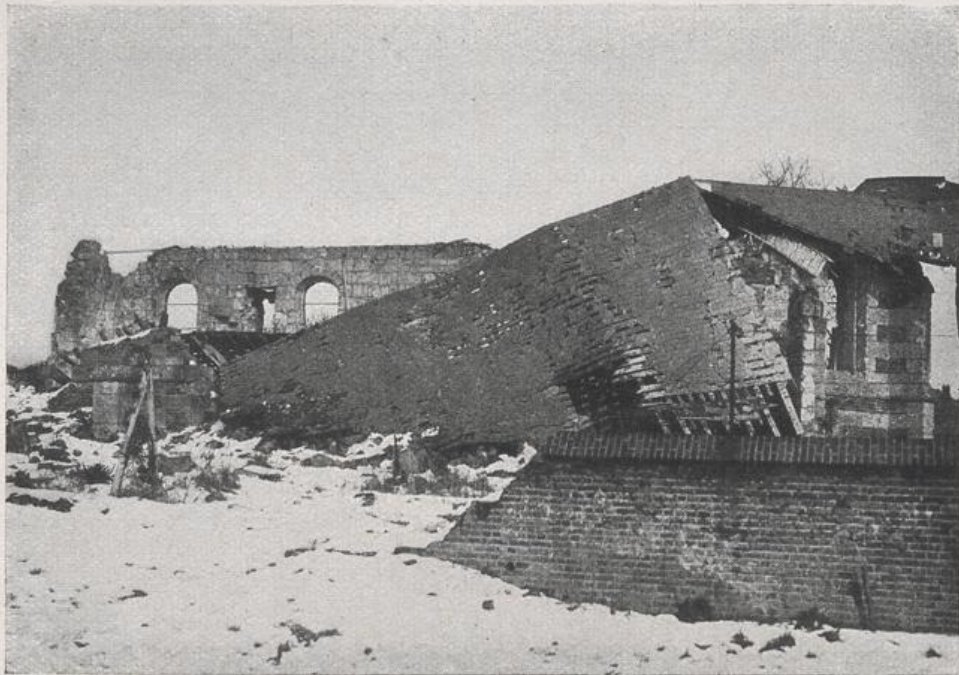
Kirche von Fresnières, völlig zerschossen durch die feindliche Artillerie
