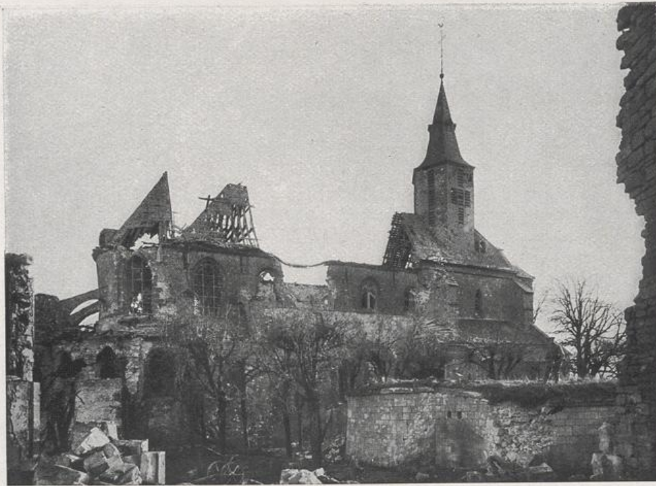
Kirche von Montfaucon im Herbst 1915. Der Bau ist seitdem bis auf den Chorstumpf durch die Franzosen völlig zerschossen.
