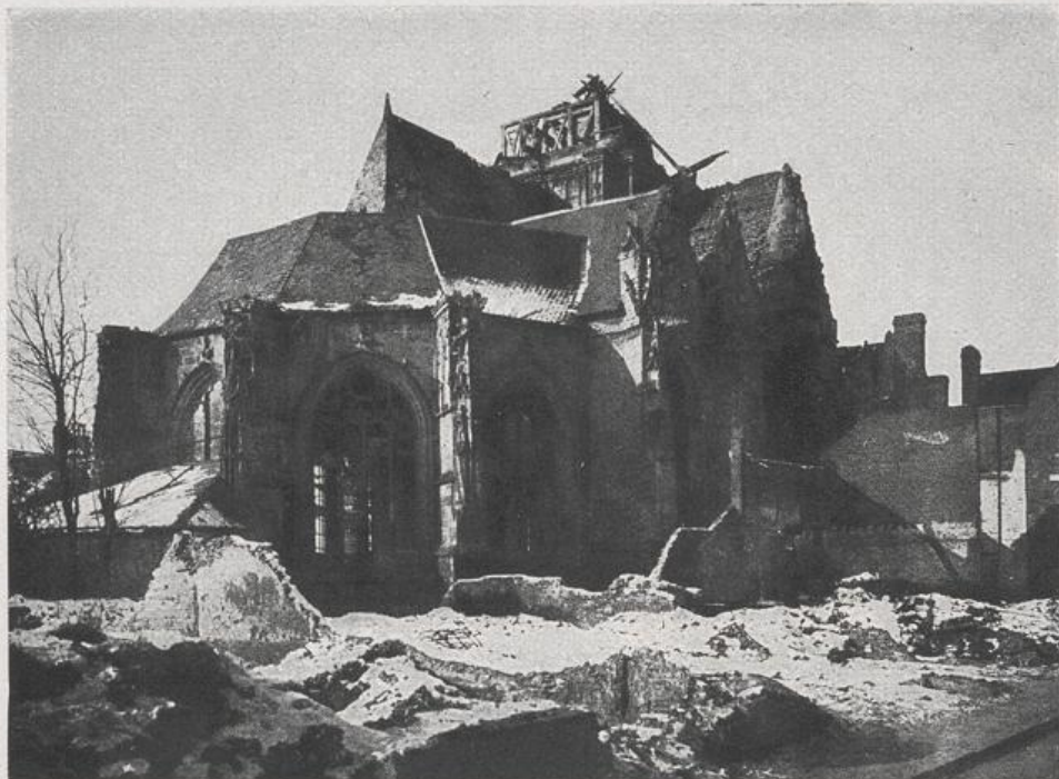
Roye. Kirche von St. Pierre nach der völligen Zerstörung durch die Franzosen. Februar 1917
