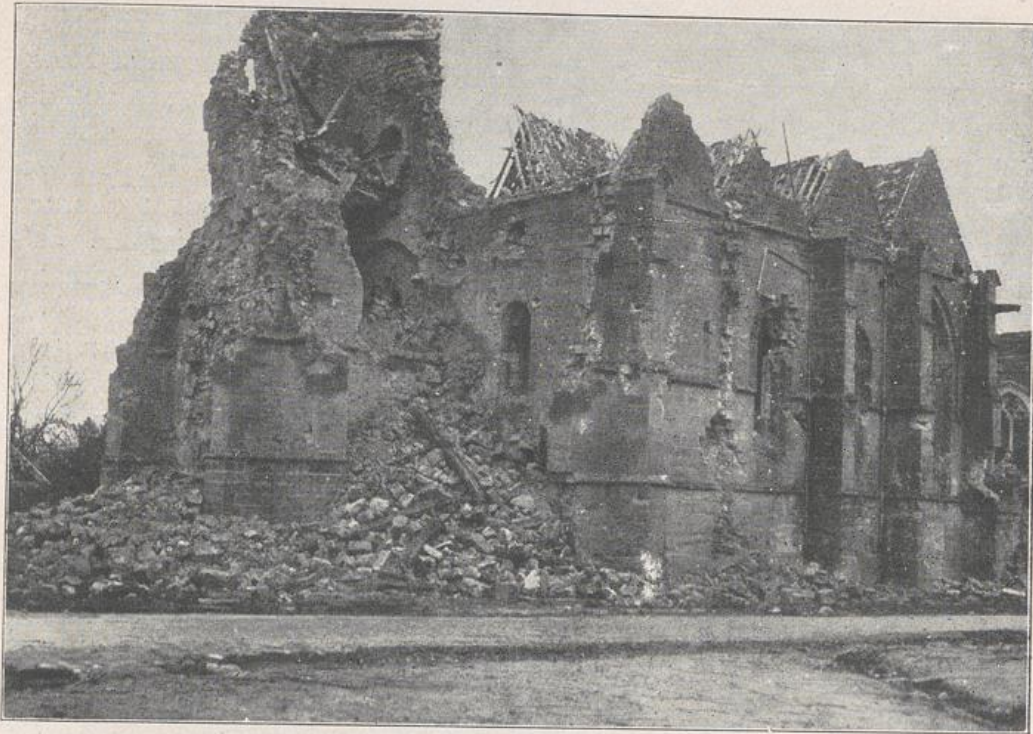
Die von den Franzosen völlig zerschossene Kirche in Lassigny 1916
