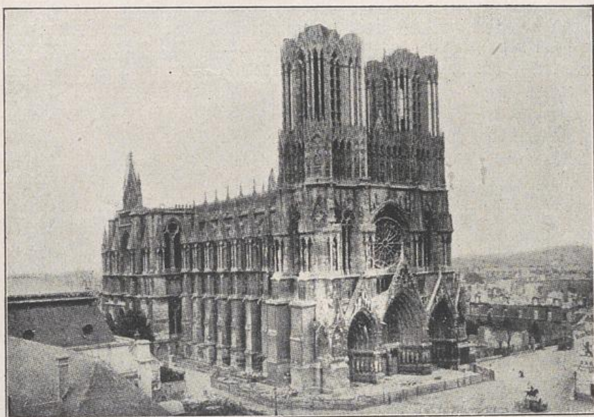
Reims, Kathedrale nach dem Brande. — Die Gegenüberstellung zeigt, dass auch nach dem Dachbrande das ganze architektonische Gerüst erhalten ist, und dass die Kathedrale keineswegs ein „Trümmerhaufen“ ist.
