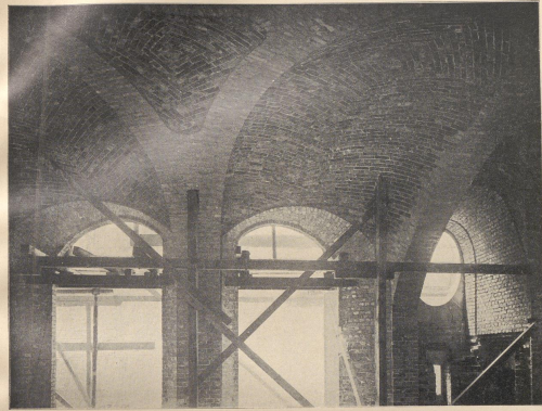
Blick nach dem Eingange, Richtung N.
