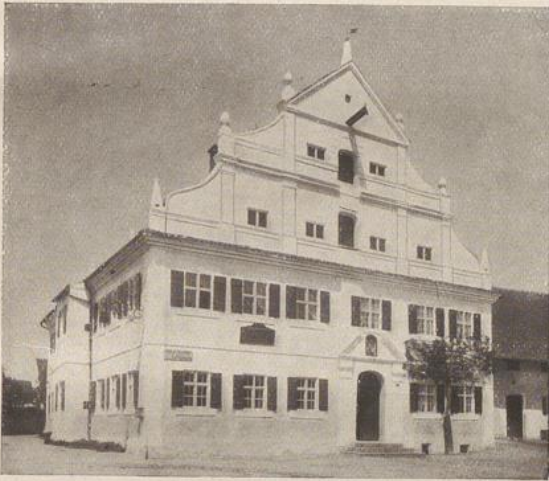
Petershausen bei Dachau: Wirtshaus. Oberbayern
