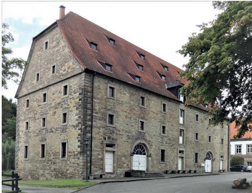
Abb. 8: Das 1722/23 errichtete Kornhaus von Kloster Hardehausen. Es hat über dem gewölbten und verschiedenen Zwecken dienenden Erdgeschoss zwei Lagergeschosse (2014). (Foto: Fred Kaspar)
