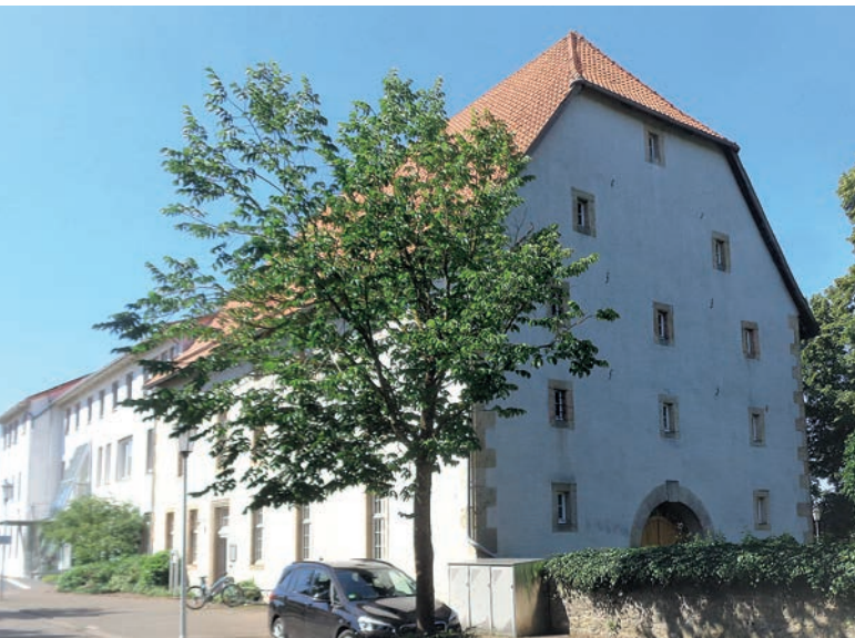
Abb. 6: Der Abdinghof Peckelsheim mit späteren Anbauten für das Krankenhaus. Heute Rathaus von Willebadessen (2020) (Foto: Fred Kaspar)
