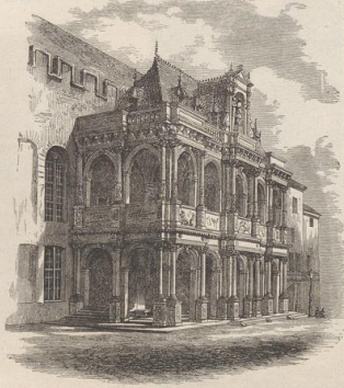
2. Rathaus-Halle zu Köln. Erbaut 1569—1571 von Wilhelm Vernickel (†).
