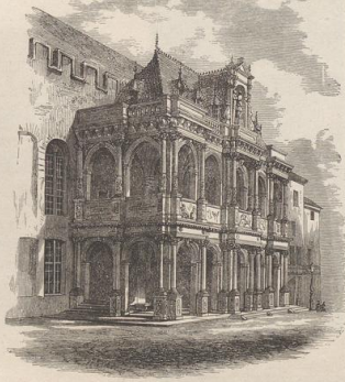
2. Rathaus-Halle zu Köln. Erbaut 1569—1571 von Wilhelm Vernickel (†).
