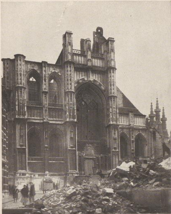
155. Löwen: Die Fassade von St. Peter nach dem Brande Louvain: La Façade de St. Pierre après l'incendie
