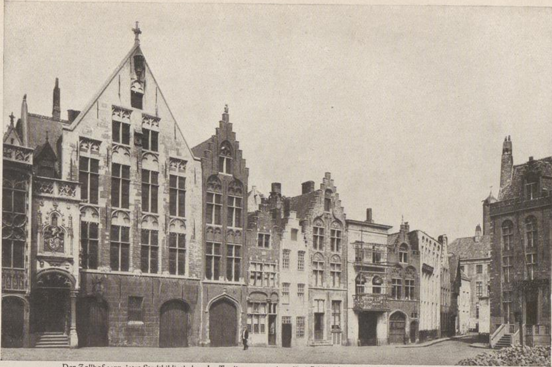
Der Zollhof 1477, jetzt Stadtbibliothek — Le Tonlieu 1477, aujourd'hui Bibliothèque de la Ville 64. Brügge: Gotische Giebelhäuser am Jan van Eyck-Platz — Bruges: Maisons gothiques à la place Jean van Eyck
