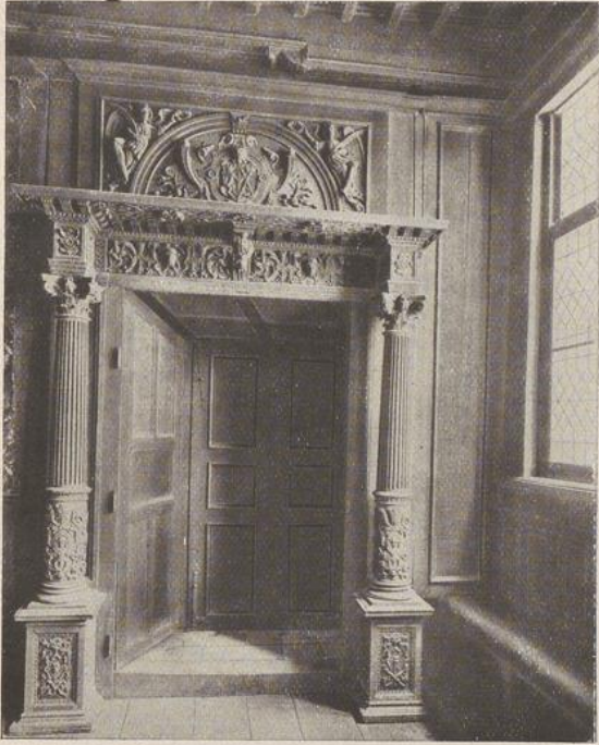
104. Veurne: Tür im Rathaus — Furnes: Porte à l'Hôtel de Ville
