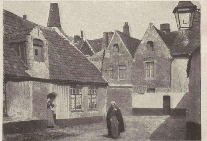
178. Brügge: Alte Gasse Bruges: Vieille ruelle
