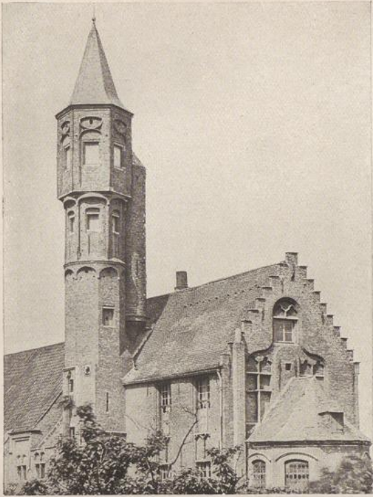
29. Brügge: Das Gildenhaus der St. Sebastians-Schützen Bruges: La Maison des Archers de Saint Sébastien
