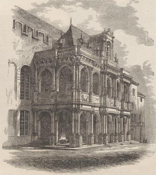
2. Rathaus-Halle zu Köln. Erbaut 1569—1571 von Wilhelm Vernickel (†).
