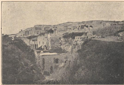
Fig. 19. Häuserruinen an der Südseite Pompejis, aufgenommen vom Standpunkt S auf Fig. 21.
