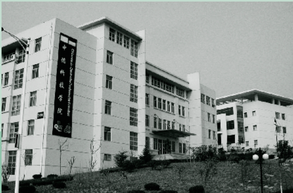
Gebäude des CDTF auf dem neuen Campus der QUST
