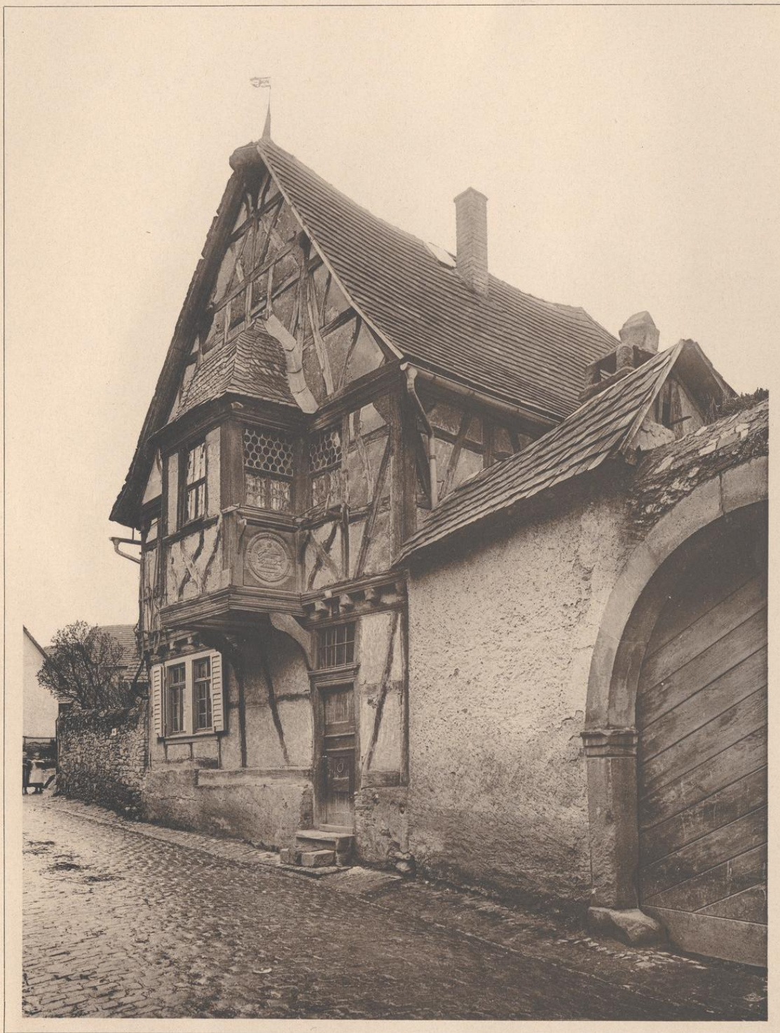
HAUS IN KIEDRICH BEI WIESBADEN. 1672.
