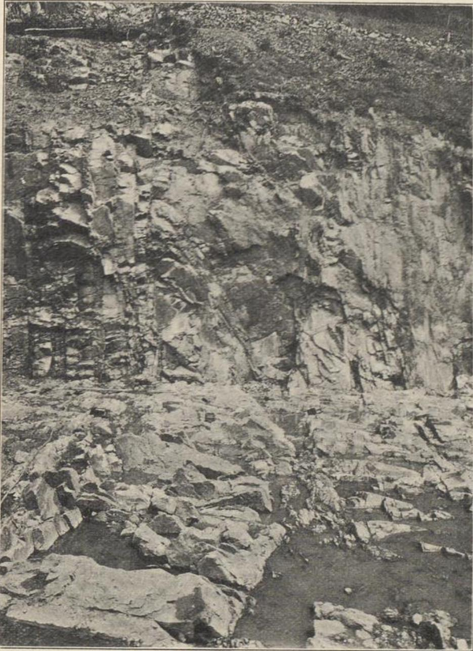
Baugrube der Sperrmauer, Linker Talhang mit Verwerfungen.
