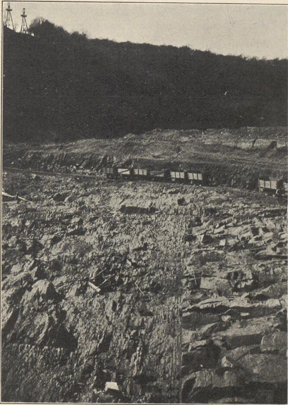
Baugrube. Grenze zwischen Grauwacke und Tonschiefer. 22. 4. 1911.
