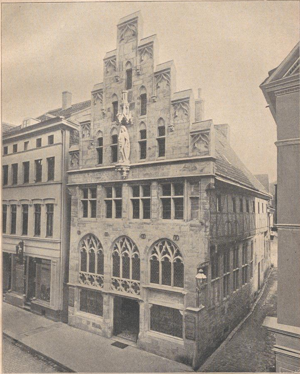
Das wiederhergestellte gotische Haus am Ostenthellweg.
