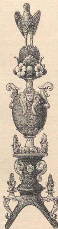
Dachbekrönung aus glasiertem Ton 323) .
