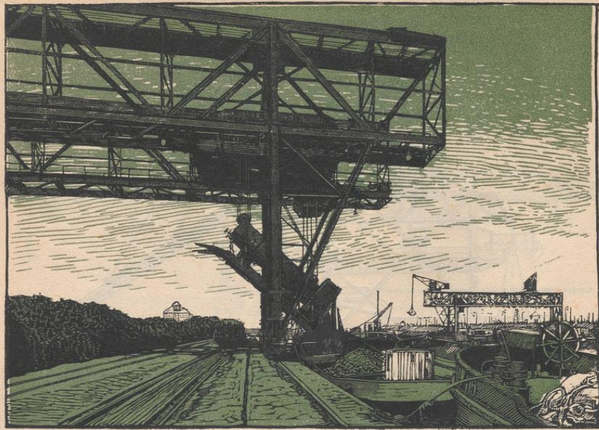
Abb. 127. Kippen eines Eisenbahnwagens mittels Verladebrücke in Wilhelmshaven.
