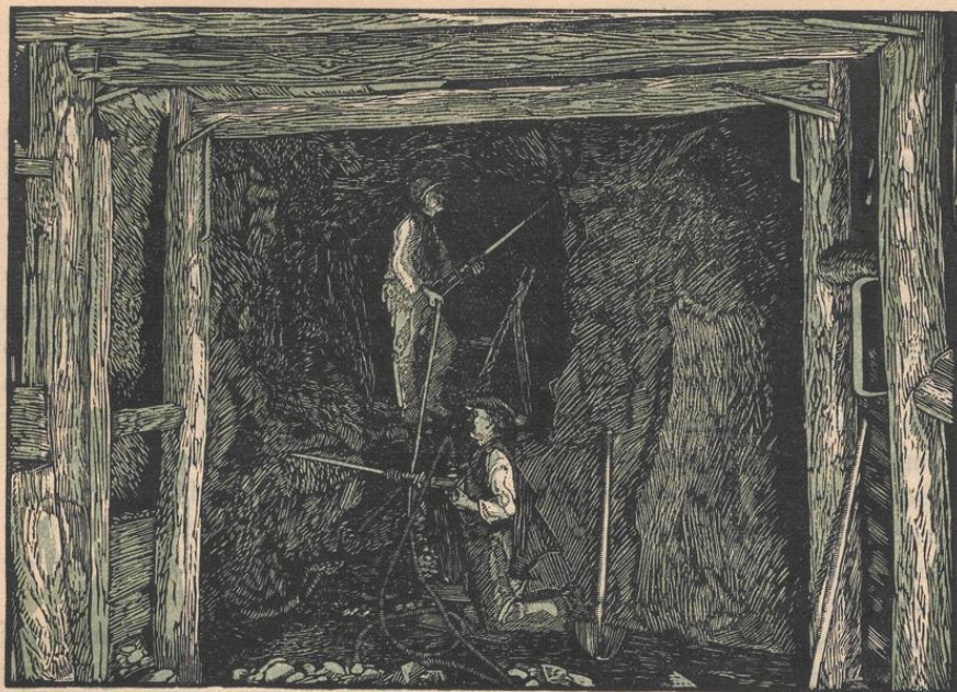
Abb. 30. Stollenvortrieb mit Preßluftbohrhämmern.
