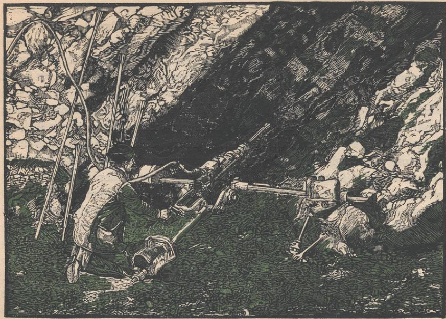
Abb. 89. Bohren eines Sprenglochs in einem Basaltsteinbruch.
