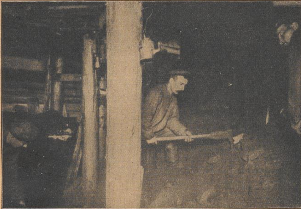
Gewinnung des Landbernsteins aus der Blauen Erde durch Tiefbau. Hauer lösen die Schicht mit der Keilhaue, der Fördermann gibt das Gut in den Förderwagen
