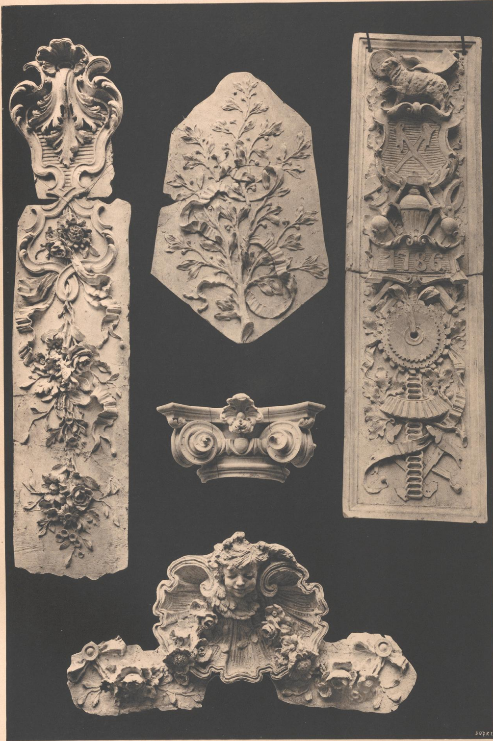
ARCHITEKTEN: EBB, MAHRENHOLZ & THRONICKER SEELING, STAHN.
