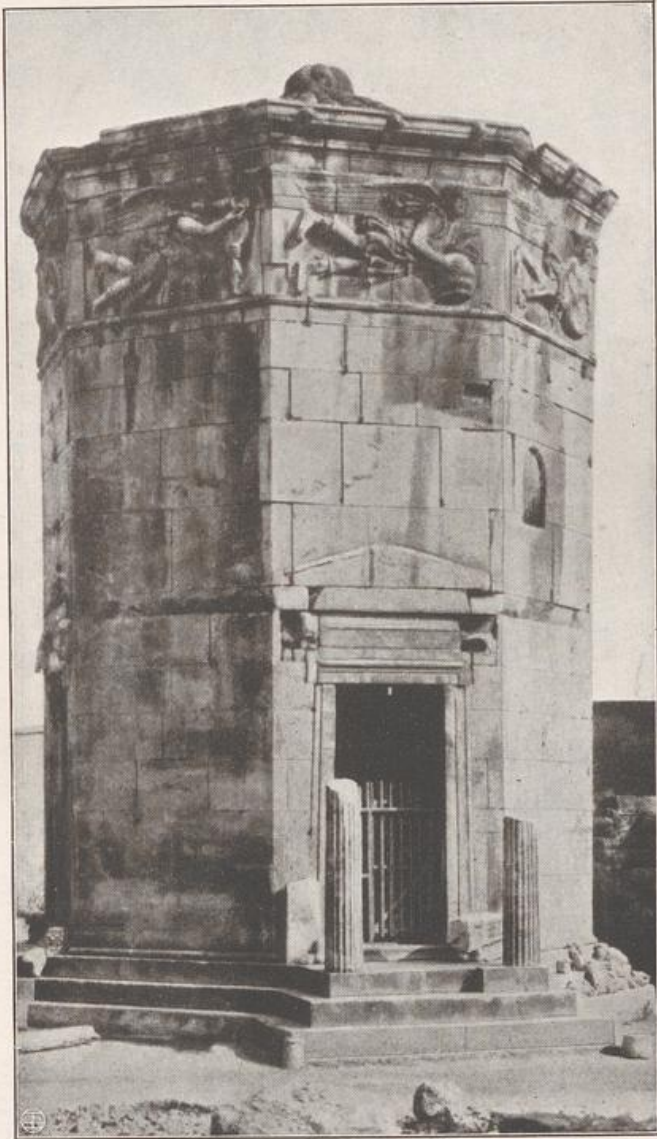
Turm der Winde in Athen. Auf der Spitze des Daches drehte sich ein bronzenener Triton, der je nach dem Winde seinen Stab über einen der acht unter dem Gesimse abgebildeten Hauptwinde ausstreckte.
