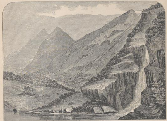
Fig. 42. Seilriese mit Pendelbetrieb. Anlage in Aalesund, Norwegen, 1872—1873, ausgeführt von Carrington.
