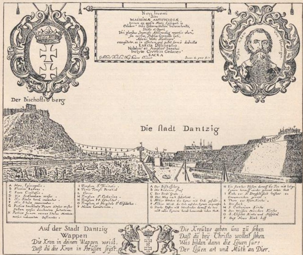
Fig. 10. Seilbahn zum Abtragen des Bischoffsberges bei Dantzig. Erbaut 1644 von Adam Wybe.
