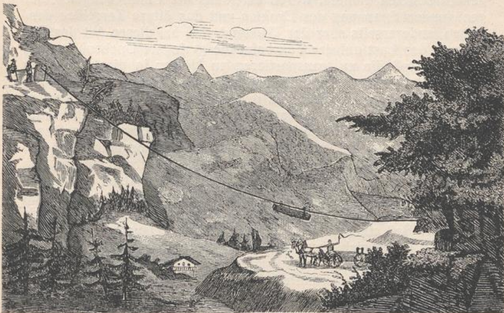
Fig. 15. Drahtseilriesen, erbaut von Hohenstein 1859 in Fai, Bez. Mezzo Lombardo.
