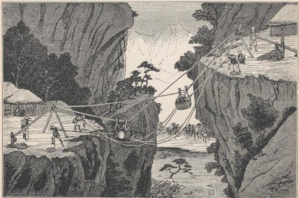
Fig. 3. Zweiseilbahn mit hin- und hergehendem Betrieb, nach einer alten japanischen Zeichnung.
